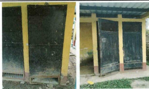
Foto 6: Debido al paso de los años las puertas se encuentran deterioradas siendo urgente el cambio de cinco puertas
