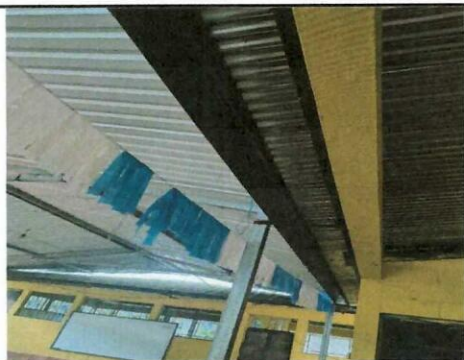
Foto 5: Los canales de techo ya estan picados y ya no son funcionales por lo que es necesario sustituirlos tomando en cuenta que tienen muchos años desde que los colocaron
