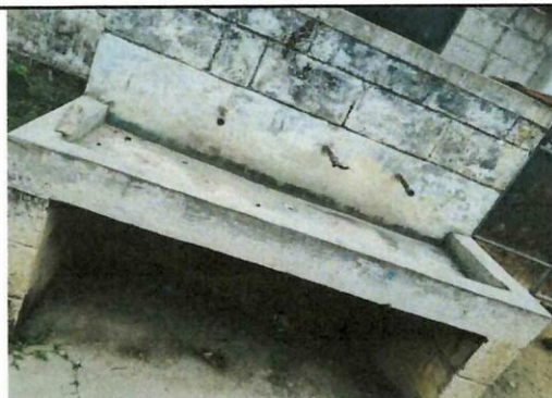
Foto 4: Remozamiento y reparacion de lavamanos
